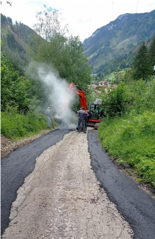
La rampa asfaltata di Val de Ota presentava profonda usura causata dai continui trasporti di legname e da erosione da acqua. Durante i temporali estivi molto spesso l'acqua trasportava la ghiaia fino sulla strada provinciale sottostante, causando disagi con il personale addetto alla manutenzione delle strade della P.A.T.
