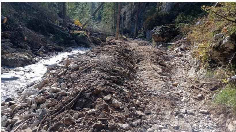
lungo la cava delle bore deteriorandola ancora di più. Si è proceduto a sistemare puntualmente l'alveo con ragno, proteggendo il manufatto e migliorando lo scorrimento dell'acqua.
