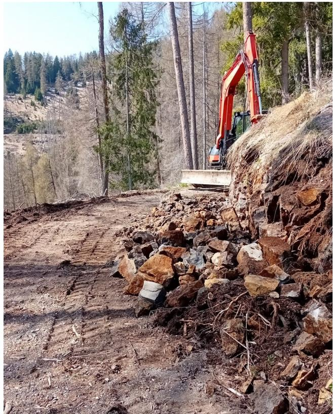
L'intervento ha riguardato esclusivamente le ripe rocciose di monte, martellando solo il necessario. Il materiale, in particolare di pezzatura grossa, è stato interrato con il metodo a trincea in corrispondenza della ripa di valle per rinforzarne la struttura della strada. Esecutrice del lavoro è stata la ditta STE.
