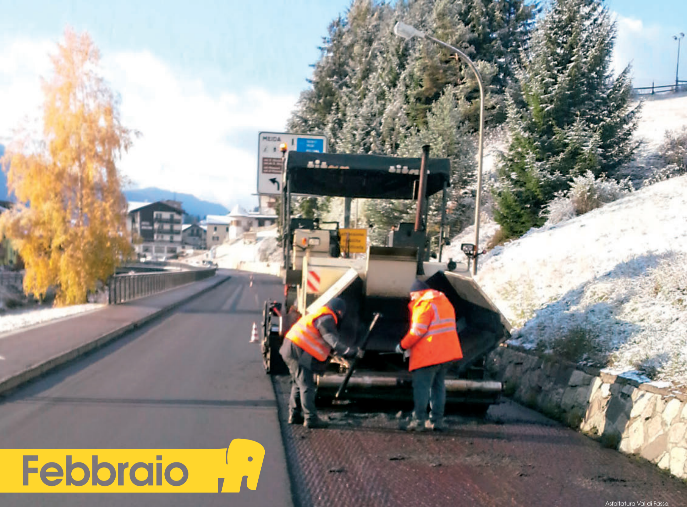
Asfaltatura Val di Fassa
