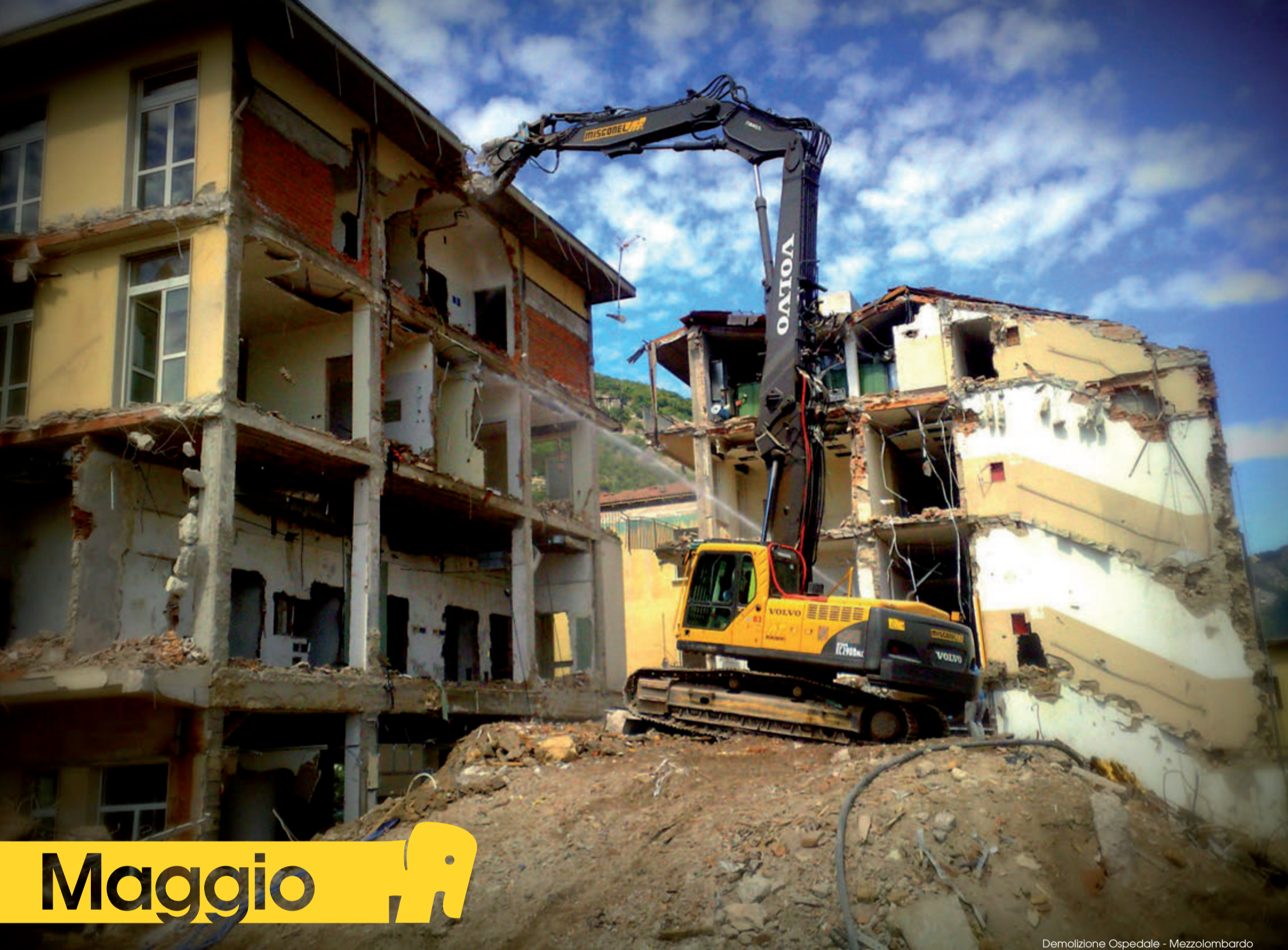
Demolizione Ospedale - Mezzolombardo
