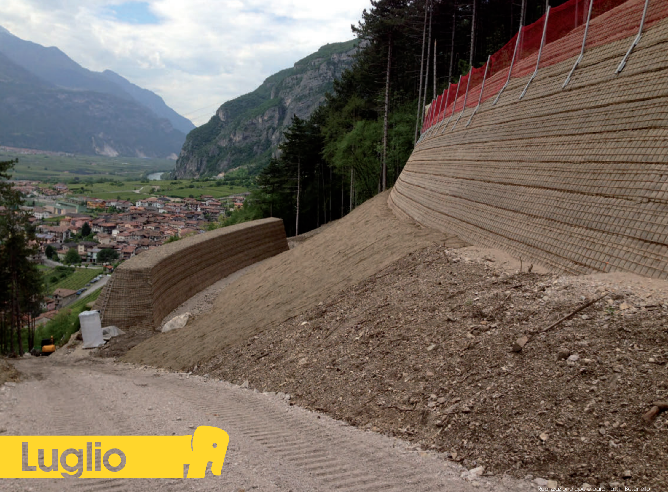
Realizzazione opere paramassi - Besenello
