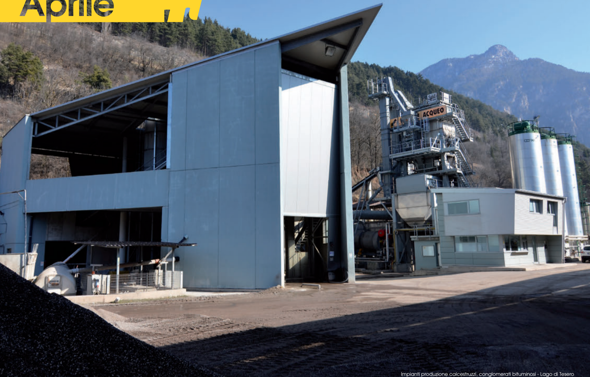
Impianti produzione calcestruzzi, conglomerati bituminosi - Lago di Tesero
