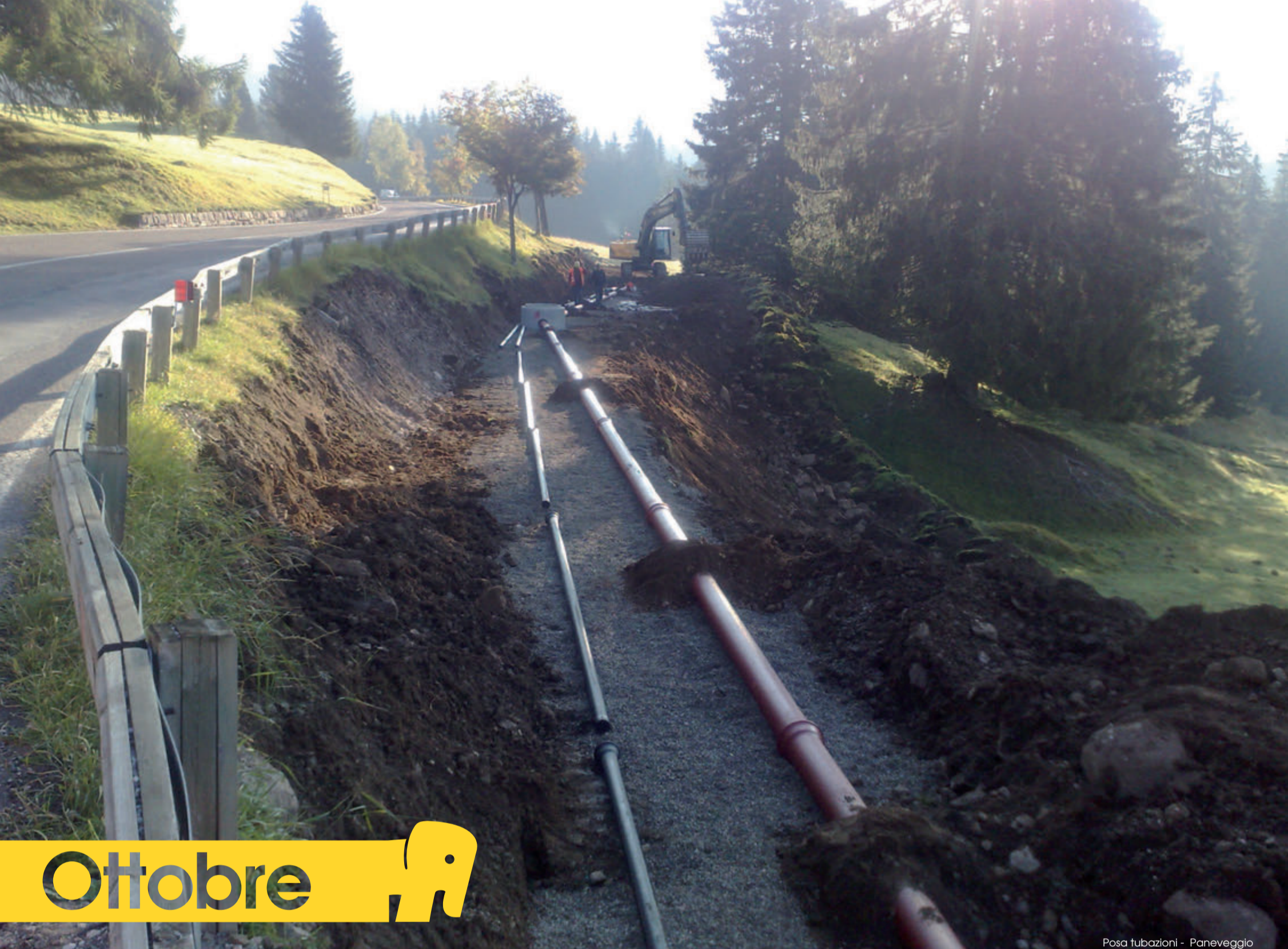
Posa tubazioni - Paneveggio
