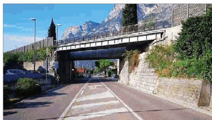
prove di carico che ne hanno evidenziato la buona salute dal punto di vista statico. Adesso completiamo l'intervento agendo sui segni di deterioramento superficiale del calcestruzzo e sul parapetto metallico in parte corrosivo, così come la piccola passerella metallica di collegamento dei due bordi del ponte. In considerazione della situa-
